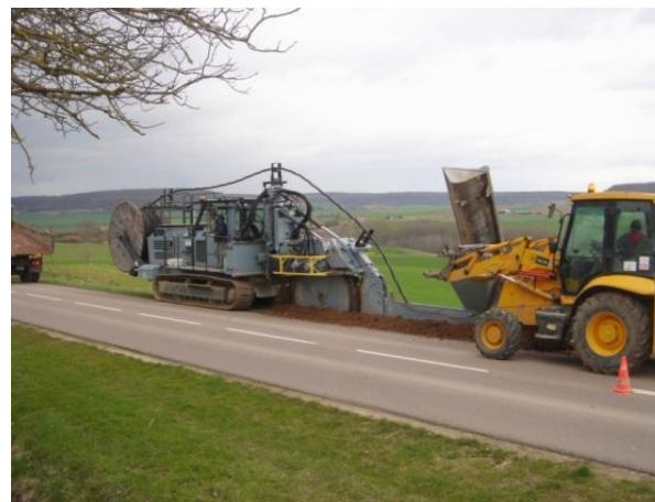
Réalisation de la tranchée
