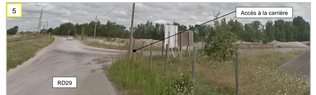
Photographie 5 : Accès au site par la carrière
