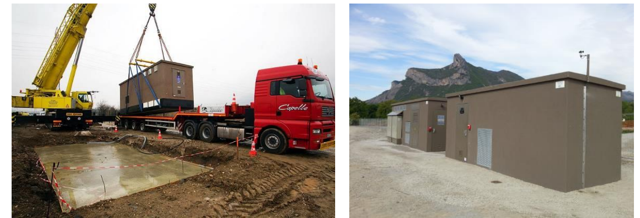
Figure 44 : Installation de postes de livraison et de transformation
