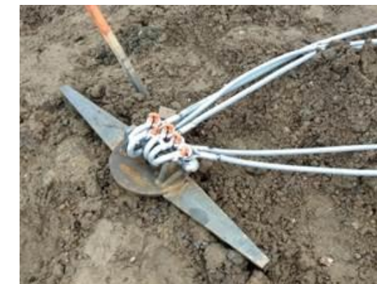
Exemple d'ancrage à vis (Source : CNR)
