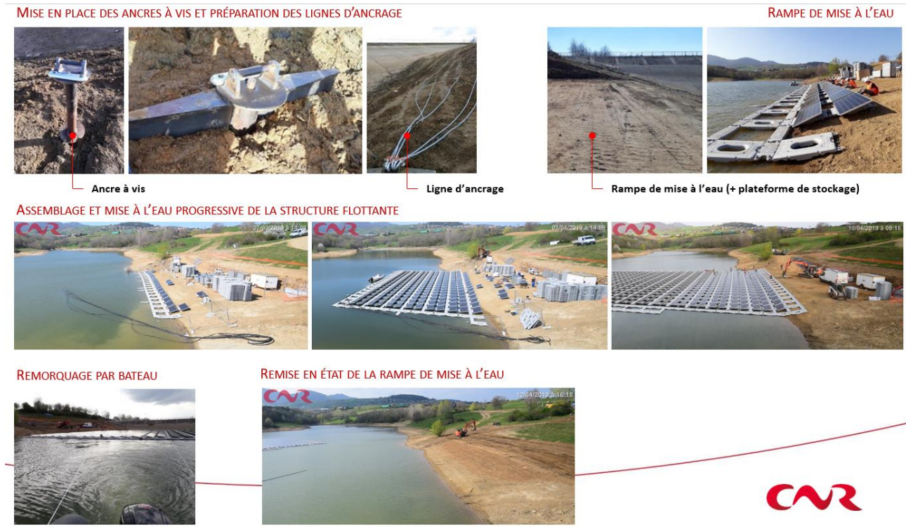
Figure 43 : Illustrations d'un chantier de construction d'une centrale photovoltaïque flottante
